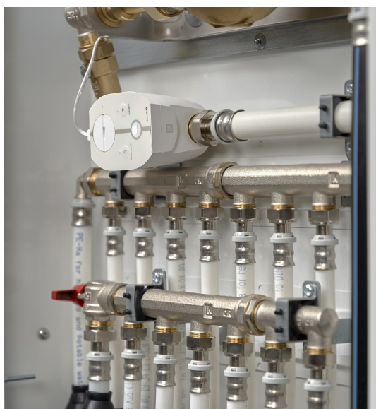
Vedenvälvontayksikkö asennettuna kaappiin.
